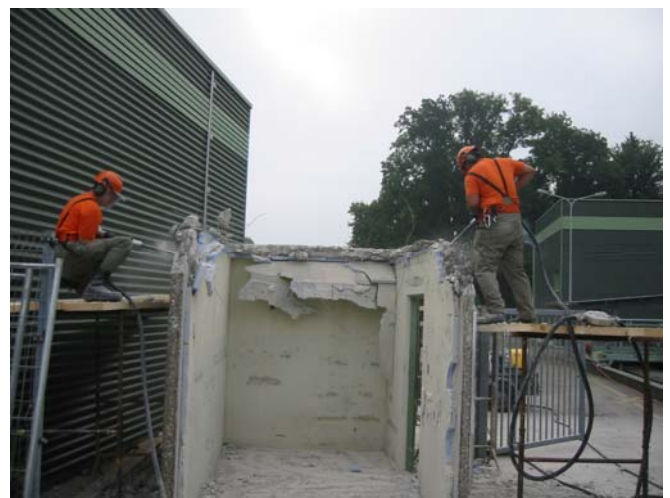
Abbruch der alten Kadaversammelstelle in der ARA Weidli, Dürnten.
